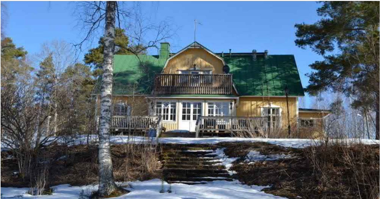
Kuva: Kuvassa alla on Kesäranta arvoluokka II.
