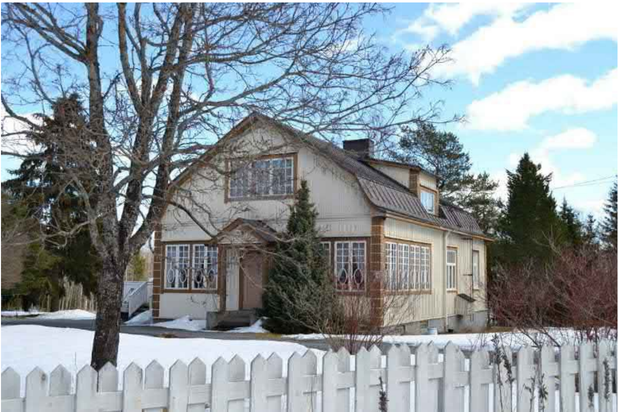
Kuva: Kuvassa alla on Urhatun leirikeskusken päärakennus. Kohde on arvoluokkaa II.
