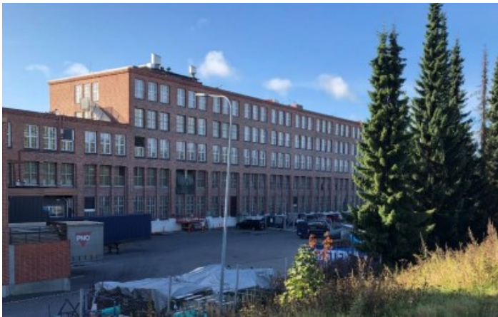
Kuva: Rengastehtaan pääjulkisivu.
