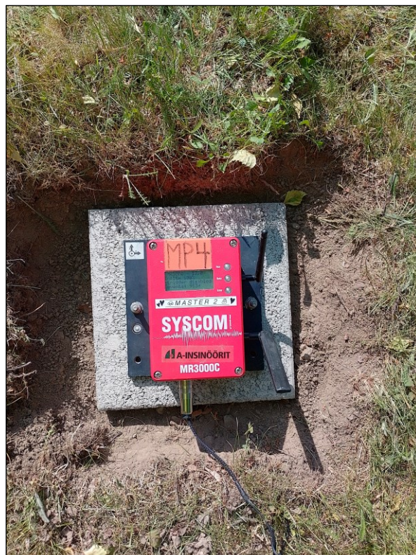
Kuva 5.2. Mittarin asennus maaperään betonilaatalle.
